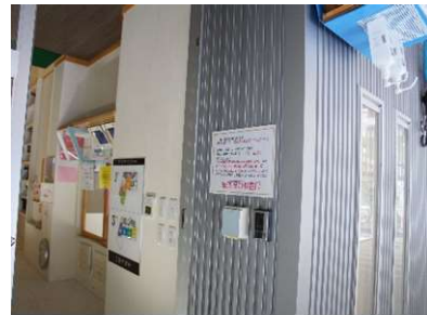
保育園入口 自動扉
